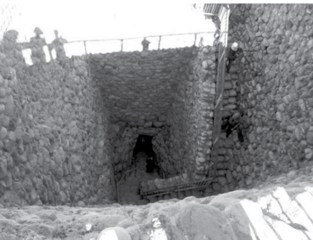
別是巴，地下數十尺的雨水蓄水池入口 2013.1.21
