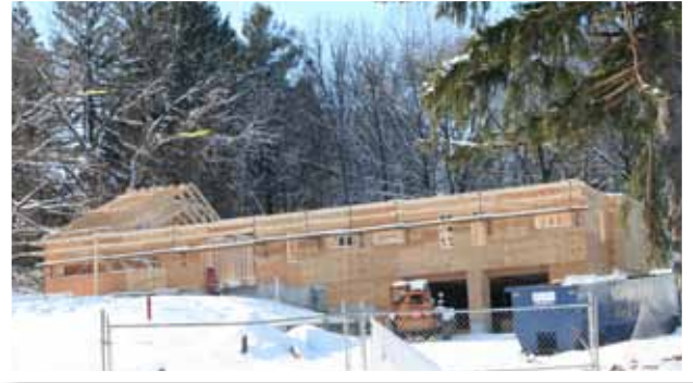
教堂擴建: 古泉街151號在施工中。
